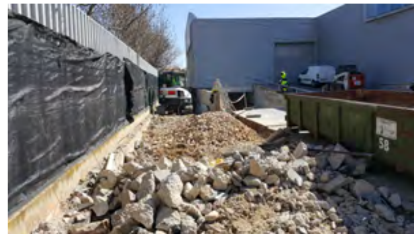
Obra de acondicionamiento de accesos al CPP
